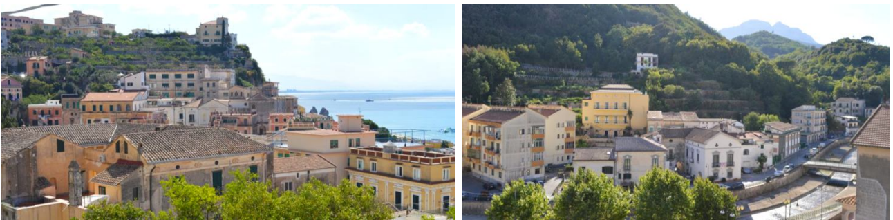
Fig.6. Examples of terracing in Vietri sul Mare.
